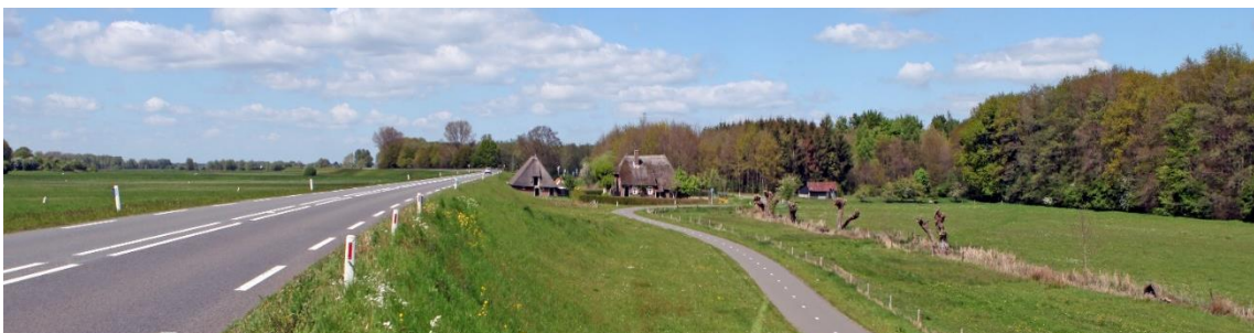
Afbeelding 6.2 Blik op deeltraject 1.1 richting het noorden met rechts een woning dicht tegen de dijk en een parallelweg
