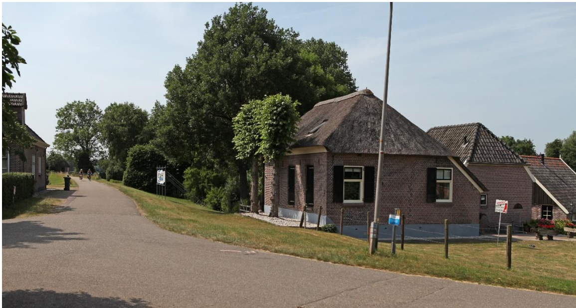
Afbeelding 6.41 Blik op de dijk richting het noorden met aan beide zijden woningen tot in het talud van de dijk
