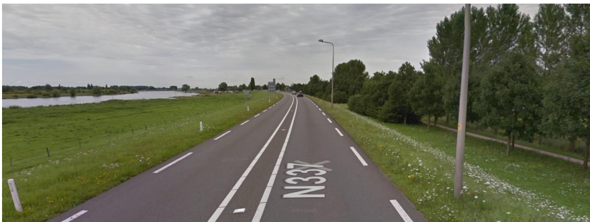
Afbeelding 6.18 Blik op deeltraject 7.1 richting het noorden met rechts de parkzone langs de waterberging (Wijhe)
