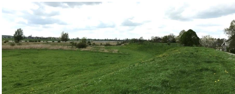
Afbeelding 6.39 Blik op de dijk vanaf het zuiden met in de buurt van de dijk een woning
