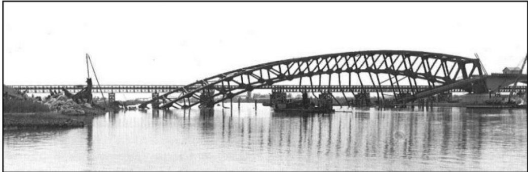
Figuur 10: Vernielde verkeersbrug bij Zwolle met op de achtergrond de door de Canadese genie aangelegde baileybrug (bron: HIL, pag. 177).
