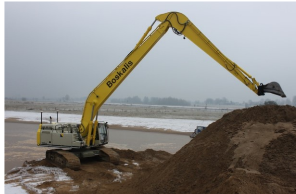
Hydraulische Graafmachine Long Reach (HGM LRE)
