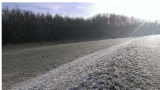
Foto 3: voormalige stortplaats Fabrieksweg 30 (locatie 40)
