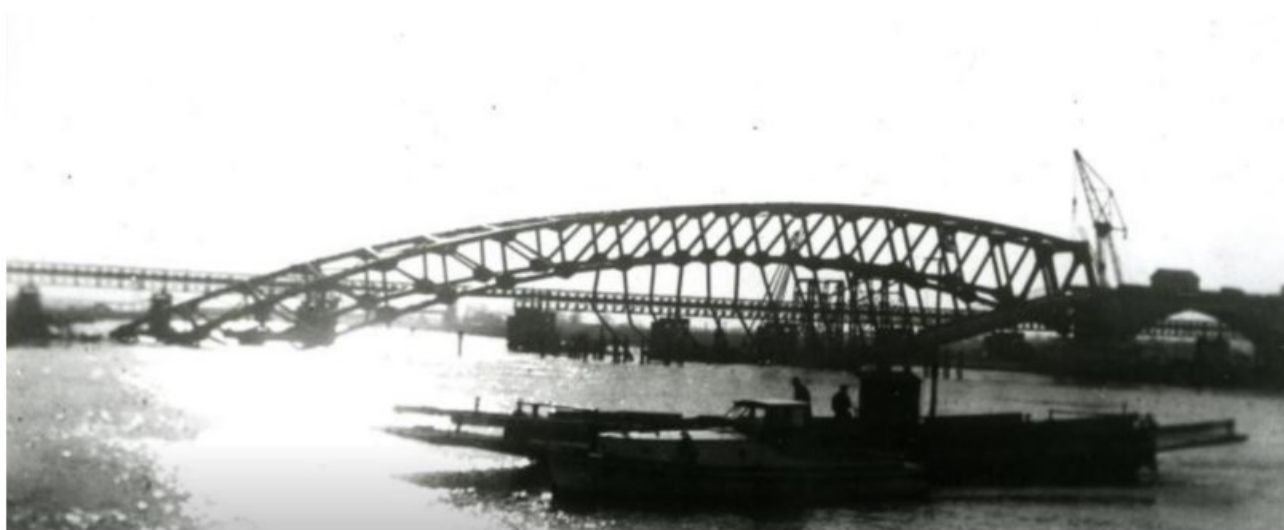
Figuur 5 Verwoeste spoorbrug over de IJssel bij Zwolle
